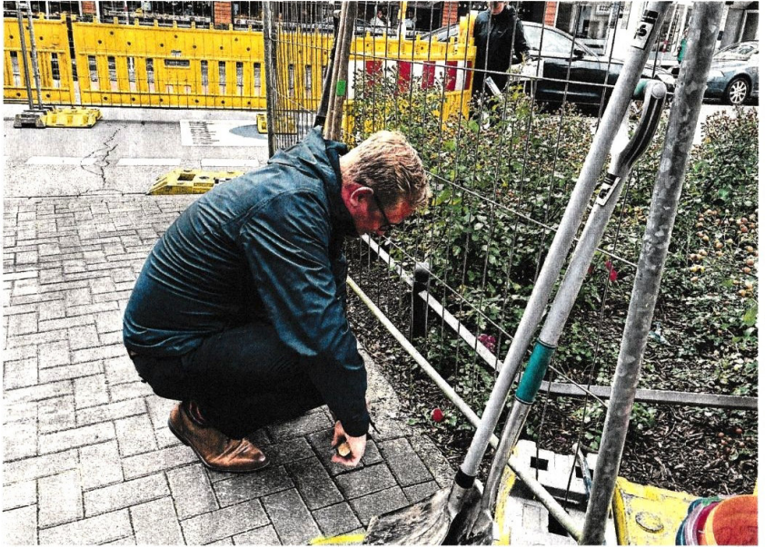
Startschuss für das »Abpflastern«: Alexander Wright entfernt den ersten Pflasterstein.
